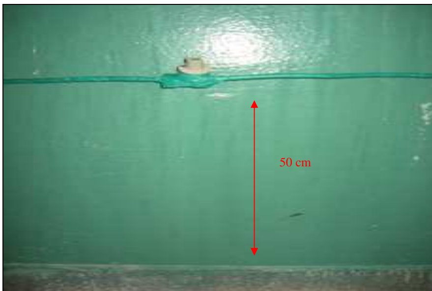
Слика 3.7.2. Реализовани вод постављен на растојању од 50 cm од пода у ходнику Електротехничке школе „Никола Тесла“ у Нишу
