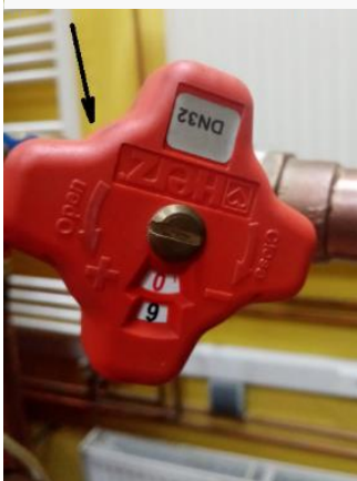
Слика 3.48. HERZ Stromax вентил у максимално отвореној позицији 6
