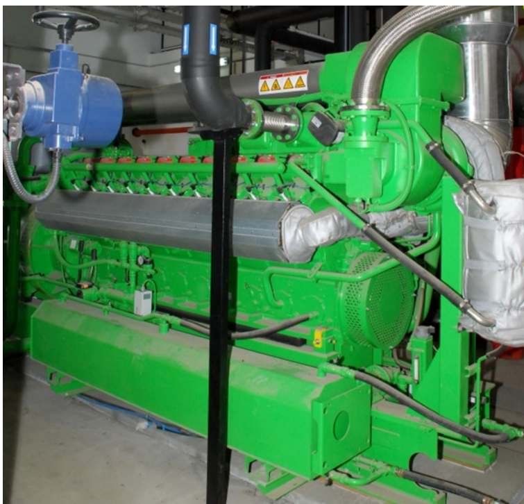
Slika 5. Motor na pogon biogasa iz digestora. Izvor: arhiva vlasnika.
