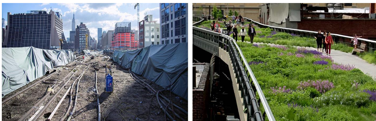
Slika 2.13. Remedijacija zapuštene železničke infrastrukture ( High line ) u Njujorku implementacijom zelenih krovova: a) izgled pre transformacije (Nunez, 2015), b) izgled nakon izgradnje promenadnog parka ( “Elevated thinking” , 2014)
