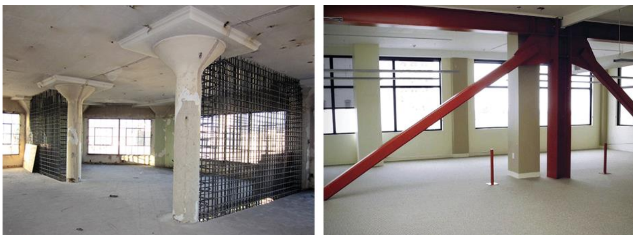
Slika 5.47. Ojačanja konstrukcija izvođenjem ukrućenja unutar gabarita objekta (Aguilar, n.d.)
