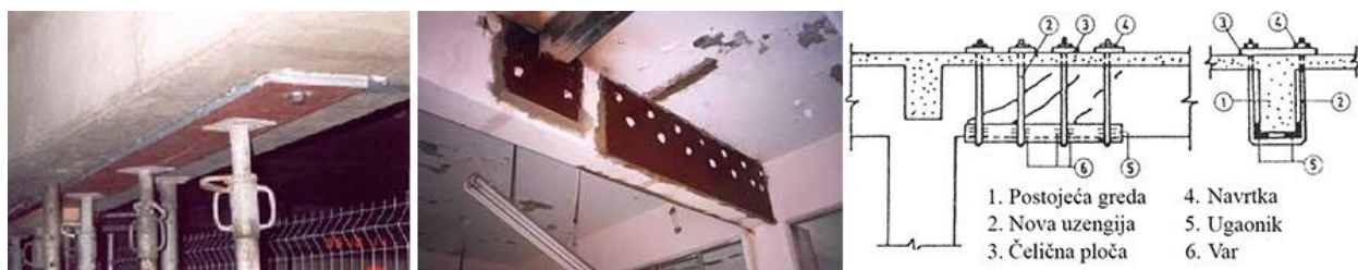
Slika 5.33. Ojačanje greda čeličnim elementima (Hassan, 2007; Najdanović, n.d.; Sistonen & Al-Neshawy, 2016)
