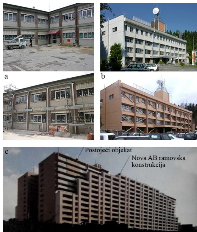
Slika 5.48. Ojačanja konstrukcija izvođenjem spoljašnjih ukrucenja (a – Foraboschi, 2016; b – „Retrofit“, n.d.; c –, „Seismic retrofitting using precast elements“, n.d.)
