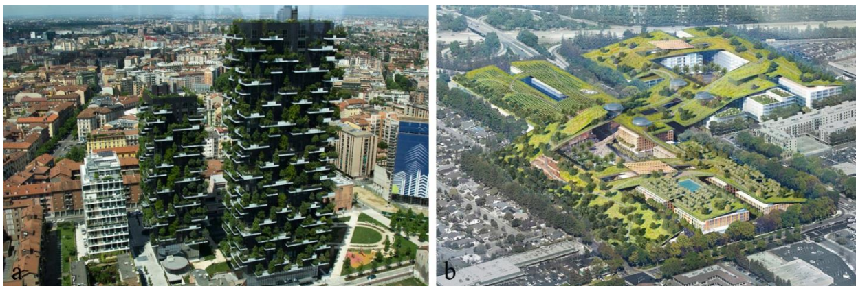
Slika 2.12. Stvaranje identiteta urbanih sredina primenom zelenih krovova: a) Objekti „Vertikalna Šuma“ (ita. Bosco Verticale ), Milano, Italija (“The incredible vertical forest”, 2016), b) Usvojeni projekat za izgradnju najvećeg zelenog krova na svetu površine 12,15 ha, Kupertino, Kalifornija (Prince, 2015)
