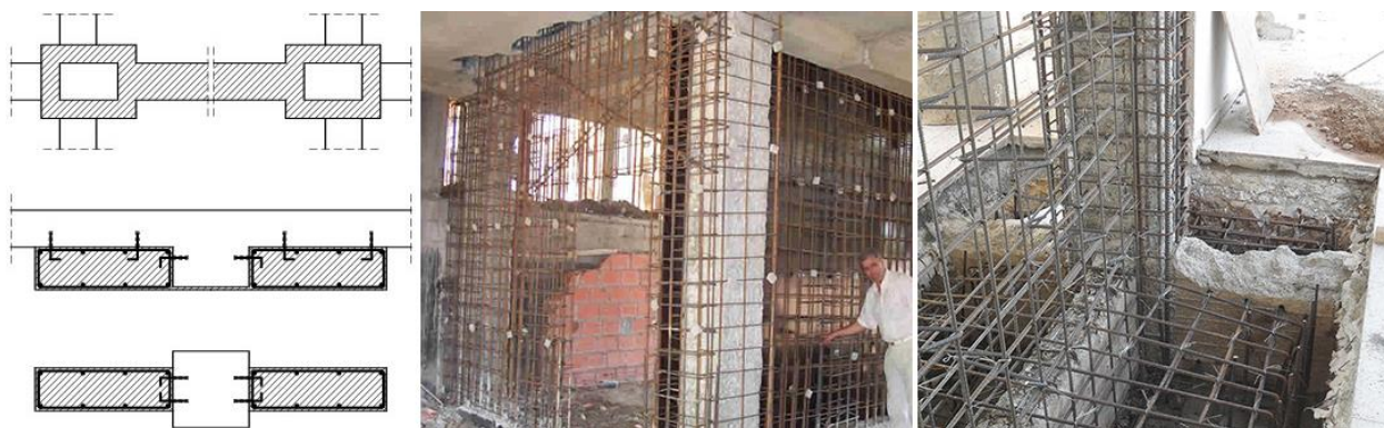
Slika 5.45. Ojačanje stubova izradom armiranobetonskih zidova (Najdanović, n.d.; „Structural & Earthquake Strengthening“, n.d.; „World Housing Encyclopedia“, n.d.)
