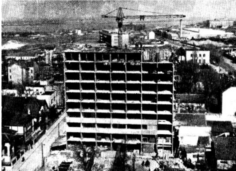
Slika 5.15. Izvođenje objekta u sistemu Trudbenik (Vukov, 1966)
