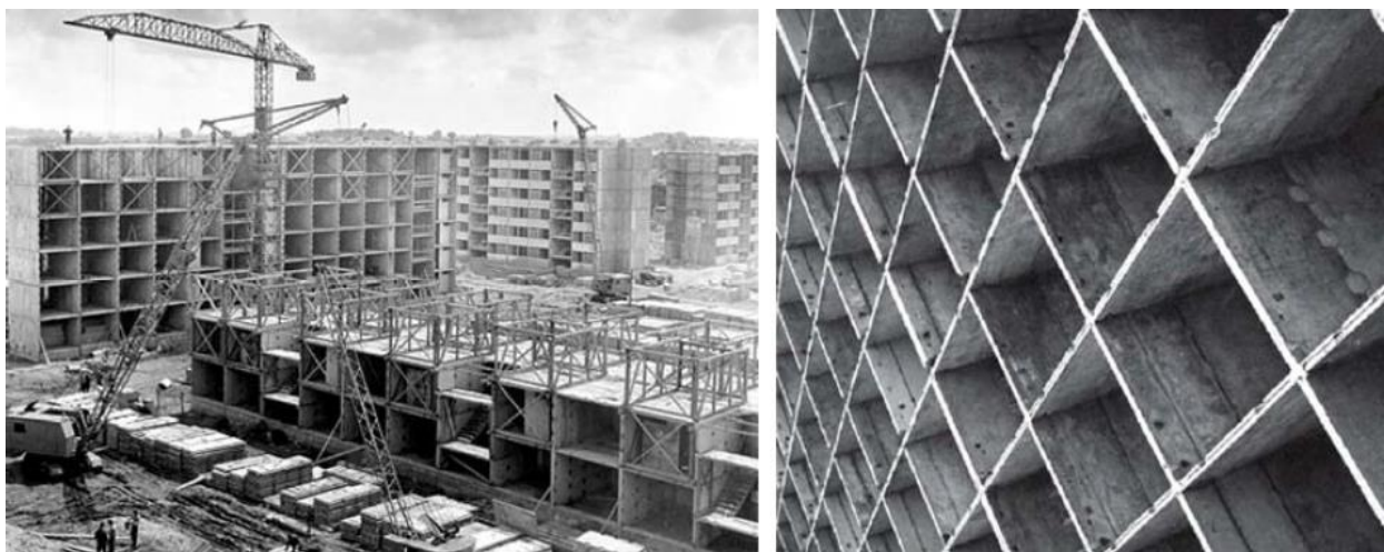
Slika 5.17. Izgradnja objekata u sistemu JU-61 (Nikolić, 2015)
