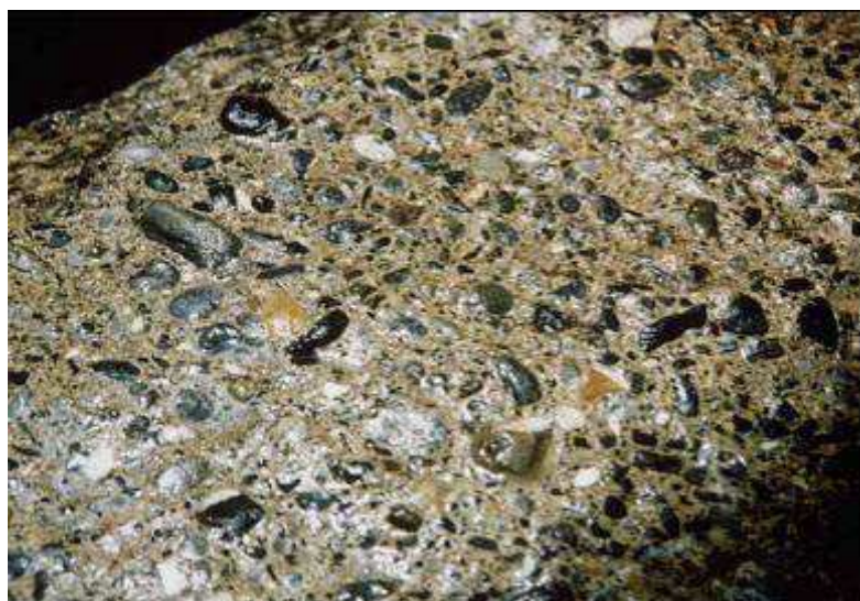
Slika 8.2.2. Prelivna ivice brane sa jasno izraženim hidro-abrazivnim oštećenjem [11]
