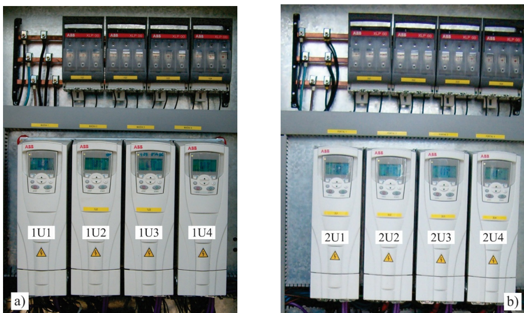
Slika 3.13. Frekvencijski pretvarači na pretovarnom mostu za pokretanje:
