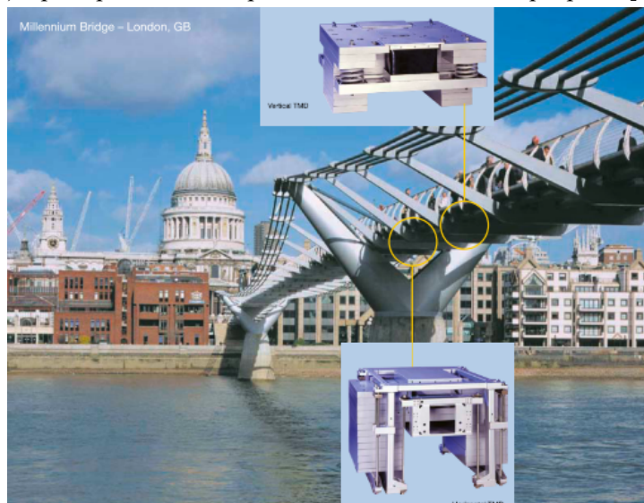
(b) Пример моста са динамичким апсорберима: Мост Миленијум, Лондон, УК [68]
