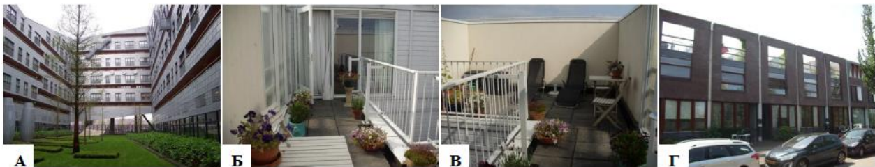
А – Атријум зграде Кит (12); Б, В – кровна тераса без вертикалних отвора на фасадама; Г – кровна тераса са отвором на уличној фасади.
