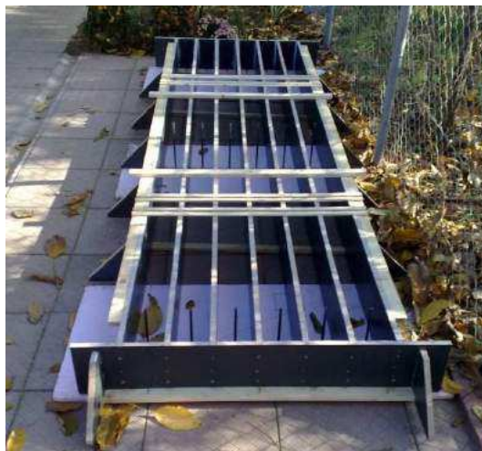
Слика 6-2: Припрема оплате – калуна
