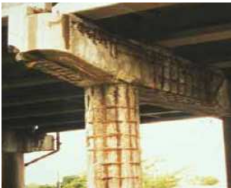
Слика 1-1: Корозија арматурног челика у стубовима мостова која је резултирала одвајањем бетонског заштитног слоја (ISIS Educational module 2,2006)
