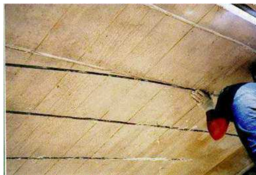
Слика 4-7: Повећавање носивости АБ елемената оптерећених на савијање (Alkhrdaji et al., 2000)
