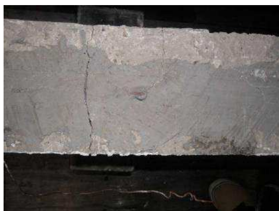
Слика 6-74: Карактеристичне прлине у епоксидном лепку (поглед одозго)
