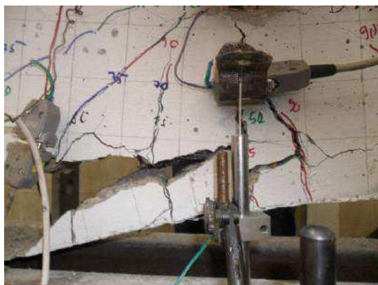
Слика 6-96: Одвајање бетона у висини заштитног слоја бетона
