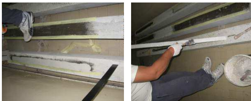
Слика 6-10: Поступак уградње ФРП ламината у оквиру ЕБ методе ојачања
