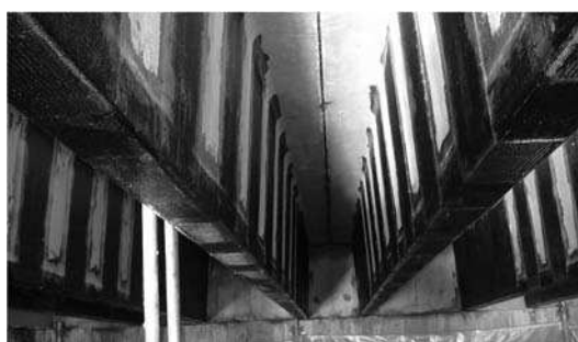
Слика 4-2: Ојачавање АБ греда на савијање и смицање ( Bank, 2006 )
