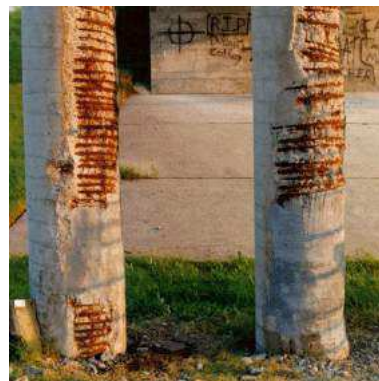
Слика 1-1: Корозија арматурног челика у стубовима мостова која је резултирала одвајањем бетонског заштитног слоја (ISIS Educational module 2,2006)
