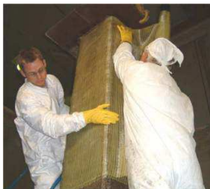
Слика 3-11: Стаклено ФРП платно примењено у ојачавању АБ стуба коришћењем технике ручног постављања (ISIS Educational module 2, 2006)
