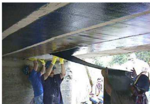
Слика 4-7: Повећавање носивости АБ елемената оптерећених на савијање (Alkhrdaji et al., 2000)
