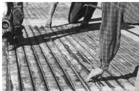
Слика 4-14: Ојачавање силоса ФРП арматуром (Enmons et al, 2001) и ојачавање горње зоне АБ моста (Warren, 1998)
