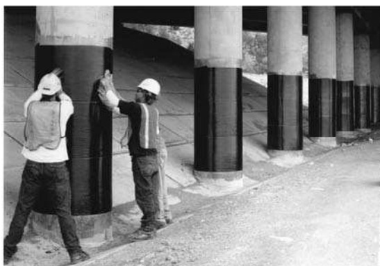
Слика 3-2: Обмотавање стубова моста платном од ФРП материјала (Bank, 2006)
