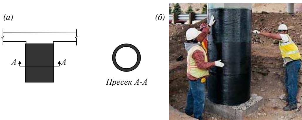
Слика 4-4: (а) Ојачање кружног АБ стуба коришћењем споља залепљене ФРП арматуре; (б) Употреба ФРП платна у ојачавању кружног АБ стуба ( http://cordis.europa.eu/documents/documentlibrary/116371391EN6.pdf )
