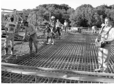
Слика 3-4: Плоча моста армирана шипкама од стаклених влакана (Vanik, 2006)
