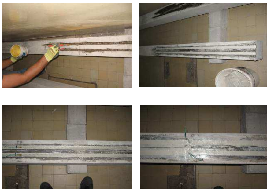
Слика 6-9: Поступак уградње ФРП шипки у оквиру НСМ методе
