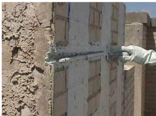
Слика 4-13: Ојачавање неармираних зидова НСМ методом (Tumialan et al., 2001)
