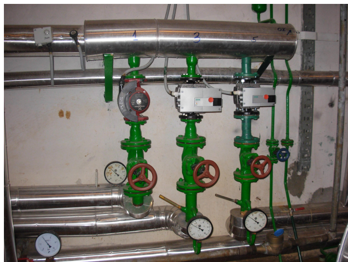
Слика 4.12 Приказ сабирника из кога се вода допрема до потрошача
