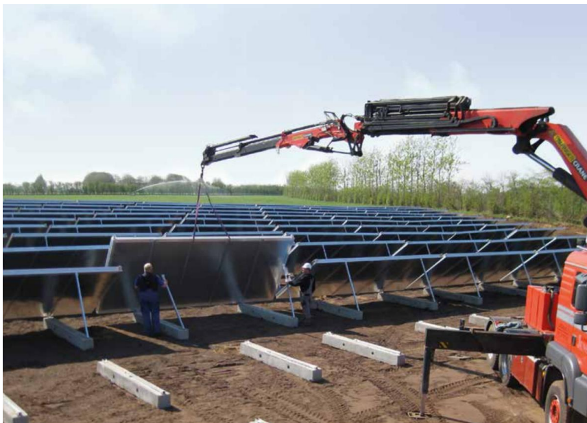
Слика 2.34 Постављање соларних колектора за будући соларни СДГ [ArconSunmark]
